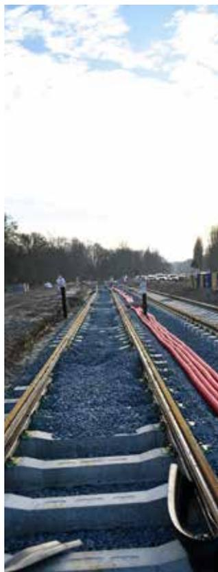
Iedereen kan zelf vaststellen dat de werf voor de heraanleg van de Woluwelaan en de verlenging van tramlijn 94 goed vordert. De twee nieuwe hoofdlanen zijn klaar en de eerste delen van de tramsporen zijn gelegd. De eerste voorzieningen voor de openbare wegverlichting en de elektriciteit voor de tram zijn geplaatst.
